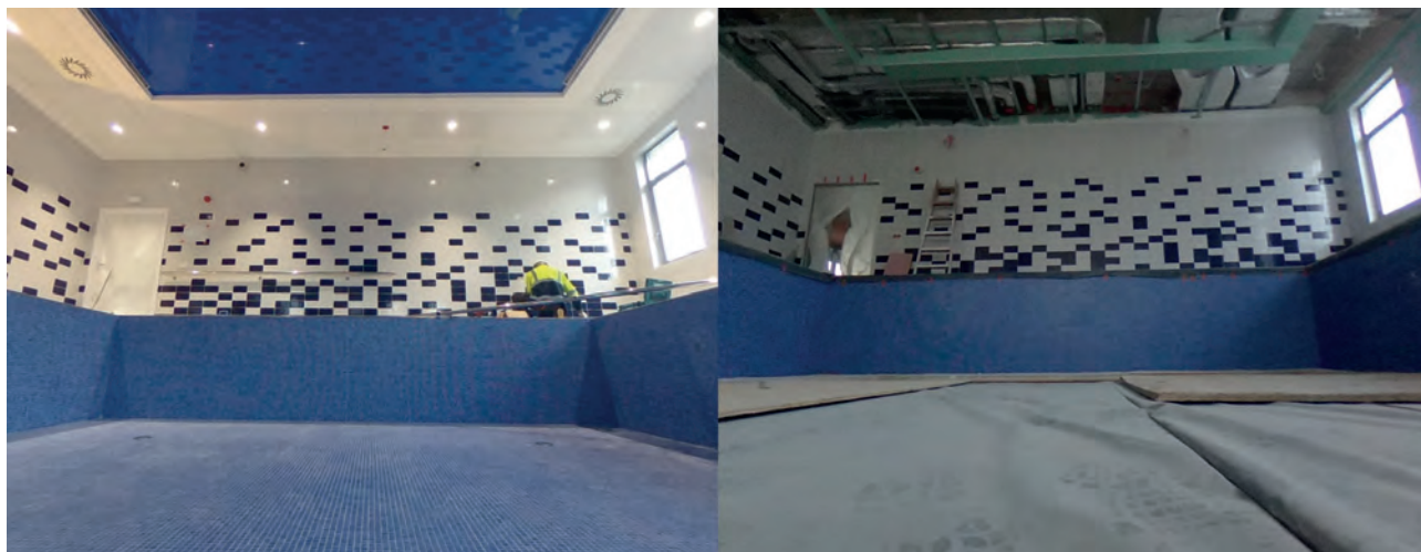
Rys. 12. Wykorzystanie zdjęć 360 do inwentaryzacji wykonanych prac – budowa kliniki Orpea w Warszawie.
