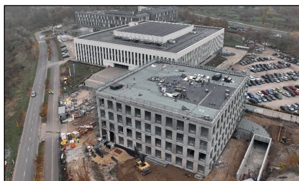
Rys. 2 Budowa nowego Rektoratu Politechniki Poznańskiej Zdjęcie zrealizowane z dronu, listopad 2024
